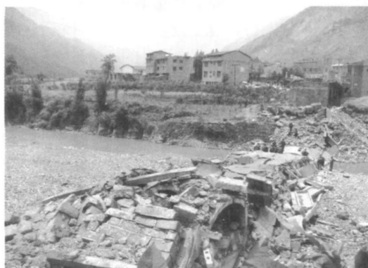
照片 4 混凝土拱桥桥梁毁坏
