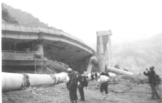
照片 5 汶川高速路桥梁破坏
