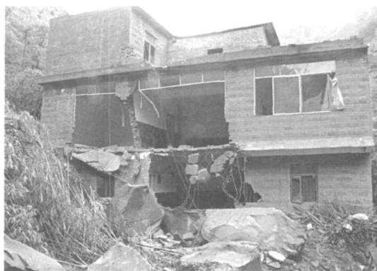
照片 2 昭通灾区水富县太平乡大河口滚石砸坏砖混民房墙体
