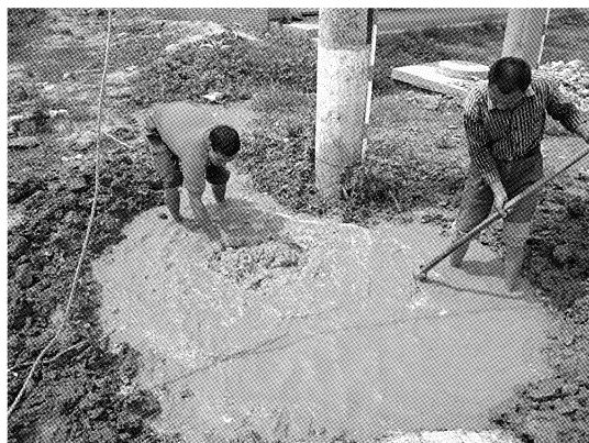
照片5 左脚舞广场西北侧自来水管爆裂涌水
