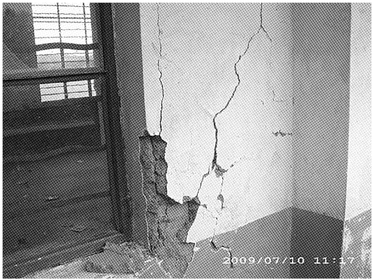
照片 3 官屯村小学砖混结构教学楼墙体开裂
