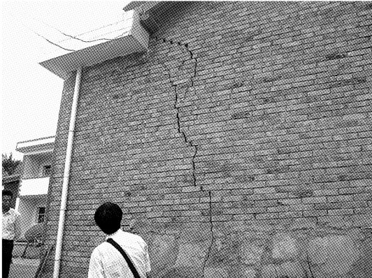
照片 2 沙桥镇米娅井村排沙组 砖木结构民房开裂
