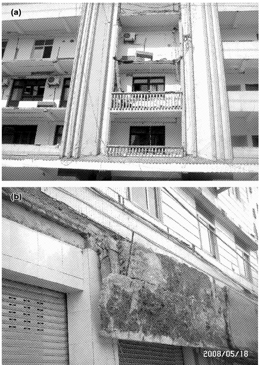
图7 栏杆破坏掉落（a）及雨篷折断（b） Fig. 7 Failure and falling of the corridor fence （a）， fracture of the cantilever canopy （b）
