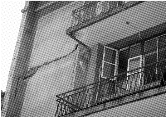
图 2 外纵墙的水平裂缝 Fig. 2 Horizontal cracks on the outside longitudinal wall
