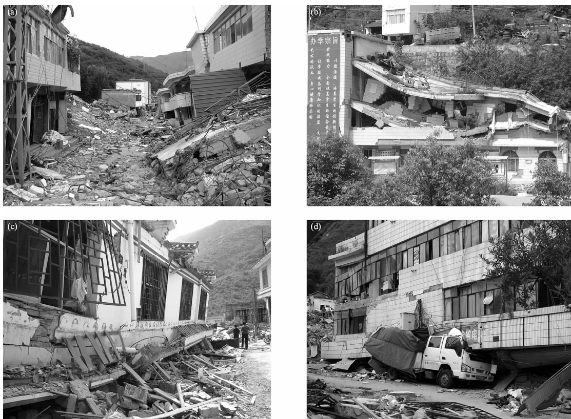
图3 龙头山砖混结构房屋破坏现场图
