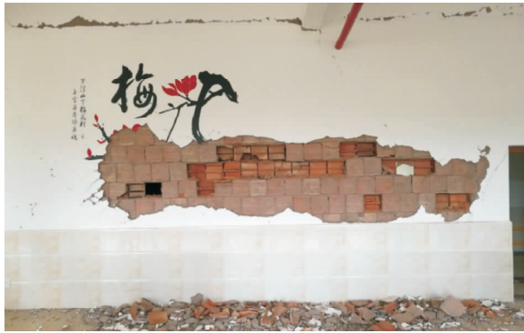
(a) 墨江县福利中心框架结构房屋填充墙破坏
