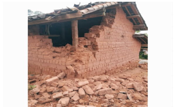
(f) 鱼塘镇梁子寨土木结构房屋墙体局部倒塌
