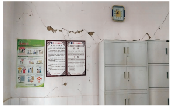
(b) 墨江县中医院砖混结构门诊楼承重墙体开裂
