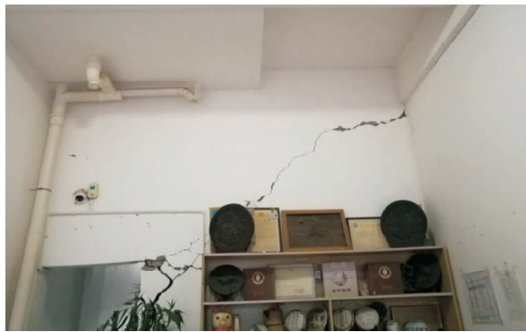
(c) 鱼塘镇和平村框架结构房屋墙体贯穿裂缝
