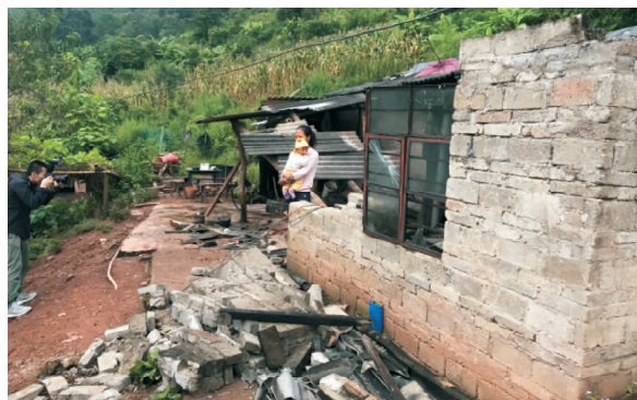
(e) 雅邑镇托洛村砖木结构房屋墙体局部倒塌
