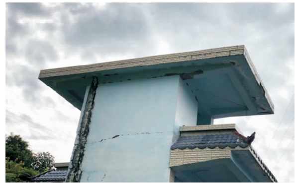
(d) 联珠镇曼嘎村老凹组砖混结构房屋墙体开裂
