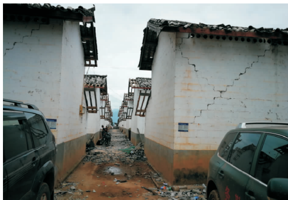
(g) 通关镇九冲和平组砖木结构房屋墙体多数开裂
