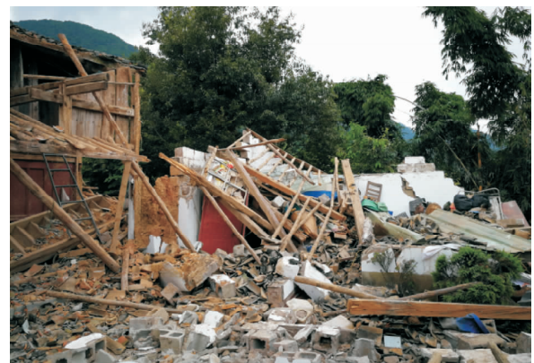
(h) 通关镇九冲和平组土木结构房屋倒塌
