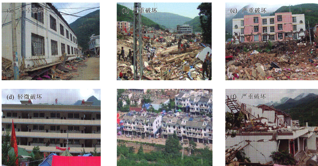
图 4 龙头山镇不同类型建筑结构破坏情况
