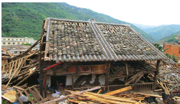
(c) 木架结构严重破坏
