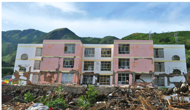
(a) 钢筋混凝土框架结构严重破坏
