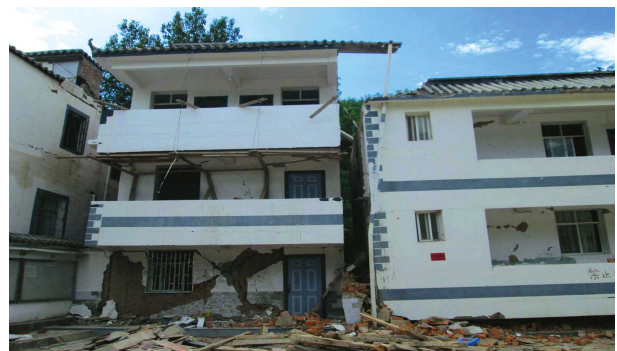
(b) 砌体结构倒塌
