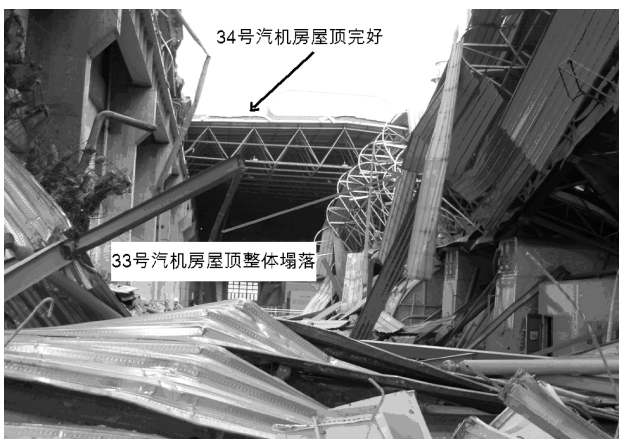
图 6 汽机房网架屋顶震害
