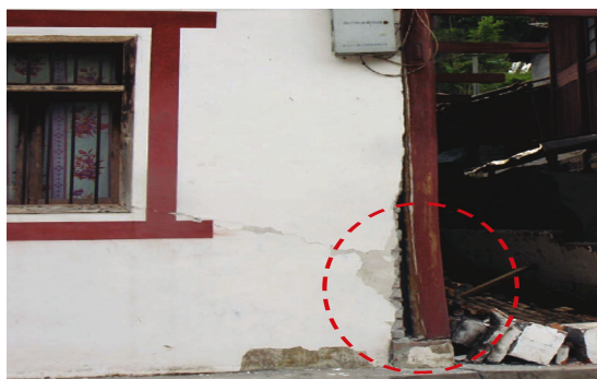
(c) 2013 年芦山 7.0 级地震Ⅷ度区房屋柱脚移位
