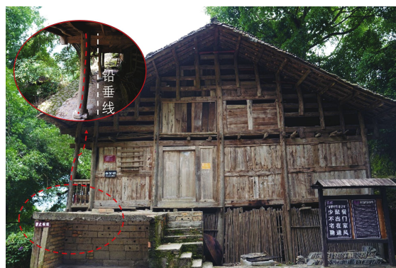
图7 穿斗式木结构房屋侧脚处理
