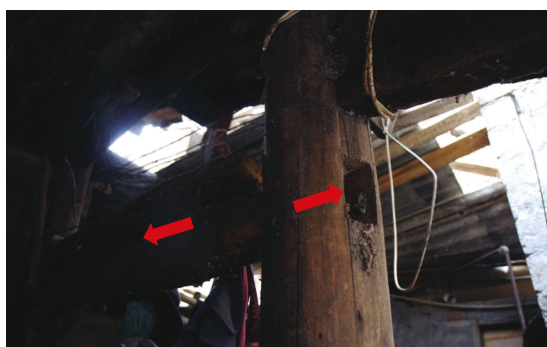
(a) 2013 年芦山 7.0 级地震Ⅷ度区房屋榫卯节点脱开
