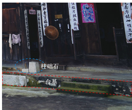
图9 穿斗式木结构房屋基础部分
