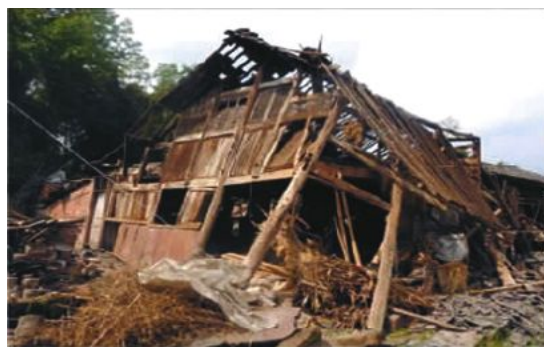
(d) 2013 年芦山 7.0 级地震Ⅷ度区房屋木构架纵向倒塌
