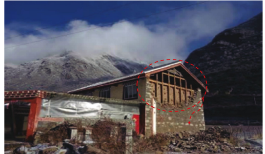
(a) 2014 年康定 6.3 级地震 VIII 度区房屋山墙倒塌
