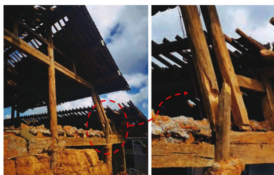
(b) 2021 年漾濞 6.4 级地震Ⅷ度区房屋木柱折断
