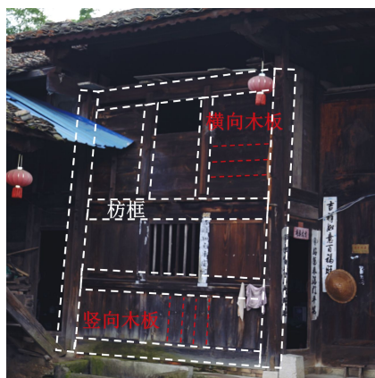
图5 穿斗式木结构房屋的木板墙拼装方式
