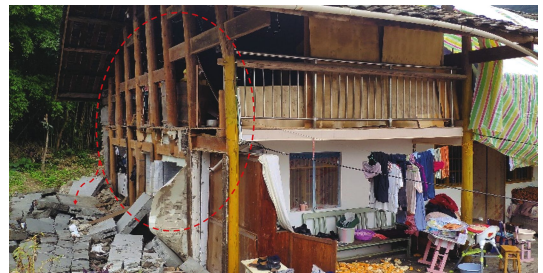
(b) 2022 年泸定 6.8 级地震 IX 度区房屋砌块墙体整体倒塌
