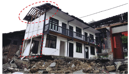
(c) 2013 年芦山 7.0 级地震 IX 度区房屋底层石膏板墙局部倒塌
