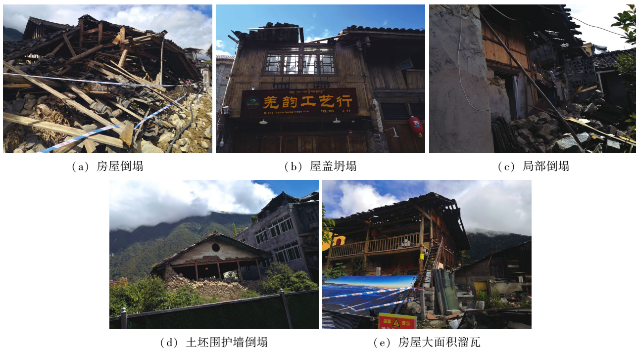
图 3 典型木结构房屋震害照片
