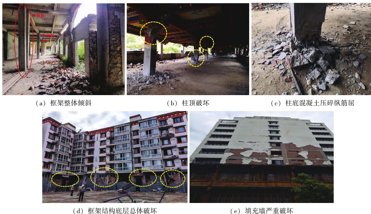
图 1 框架结构典型震害现象
