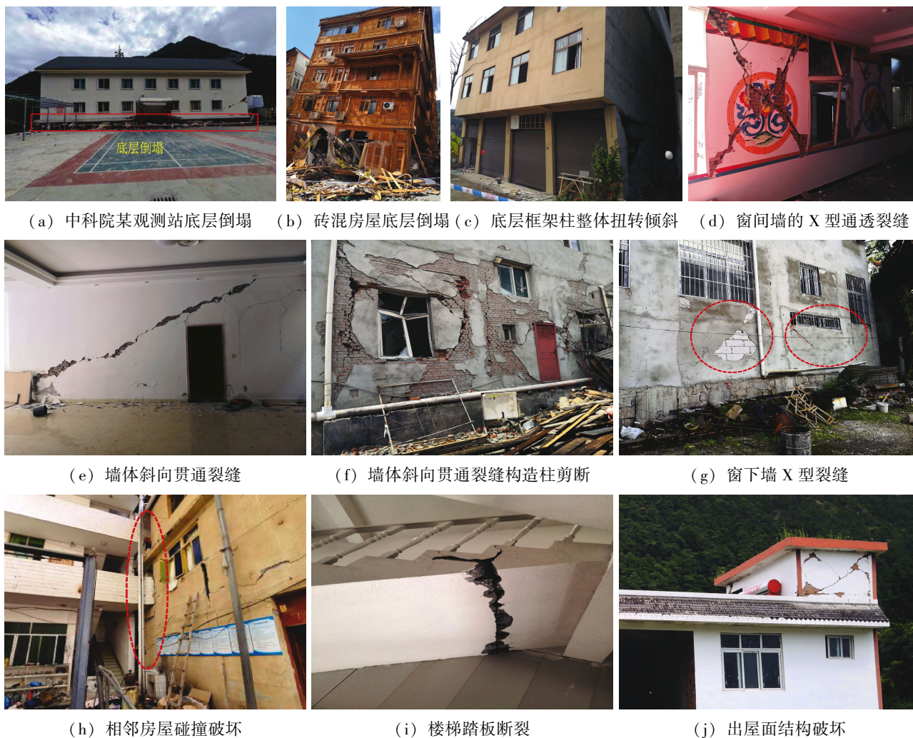
图 2 砖混结构房屋典型地震破坏
