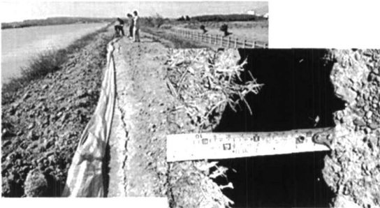
照片 2 龙銮潭水库堤岸裂缝情形
