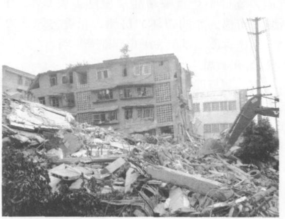
图 6 都江堰市上世纪 80 年代预制板房毁坏
