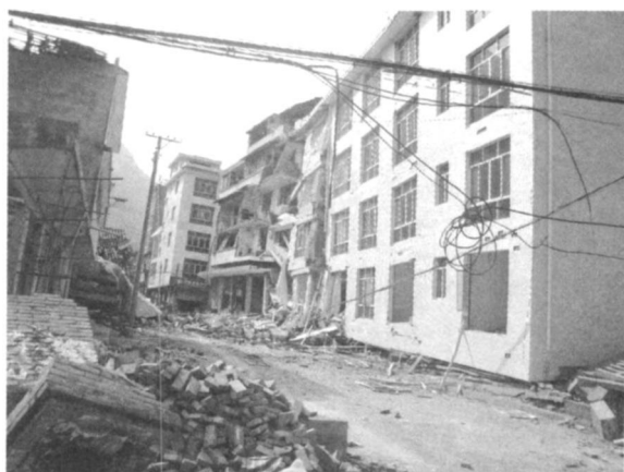
图 3 陈家坝乡砖混结构房屋毁坏
