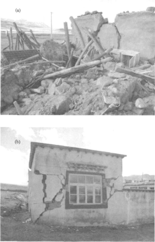
照片 1 Ⅷ度区宏观震中附近的羊易村二组土木房 (a)、砖混房 (b) 毁坏情况
