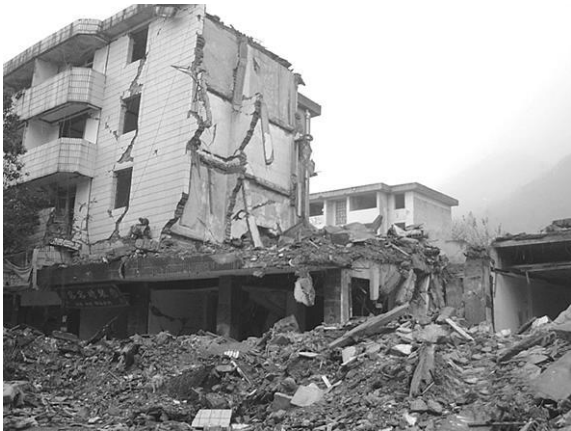
图 14 脆性材料使用的弊端 Fig 14 Disadvantages of using the brittle materials
