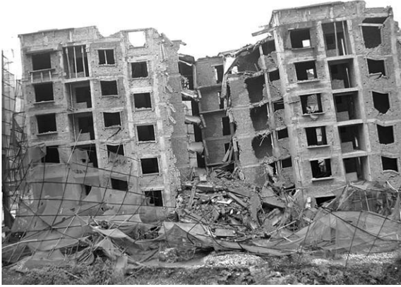
图 6 相邻两座在建工程的震后结构情况对比 (a) 框架结构结构性完好；(b) 砖混结构结构破坏严重
