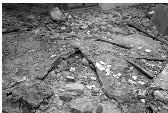
图3 砖混结构房屋的预制楼板掉落
