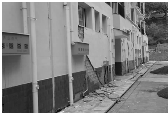
图 11 框架结构房屋轻微破坏
