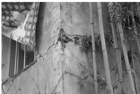
图2 砖混结构的构造柱开裂和变形
