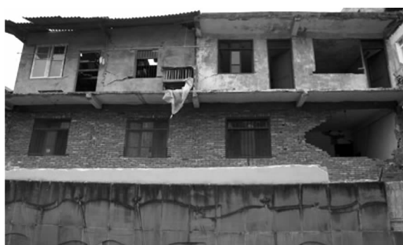
图1 砖混结构房屋局部倒塌
