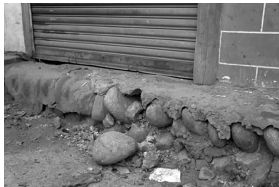
图 13 砖石结构基础破坏
