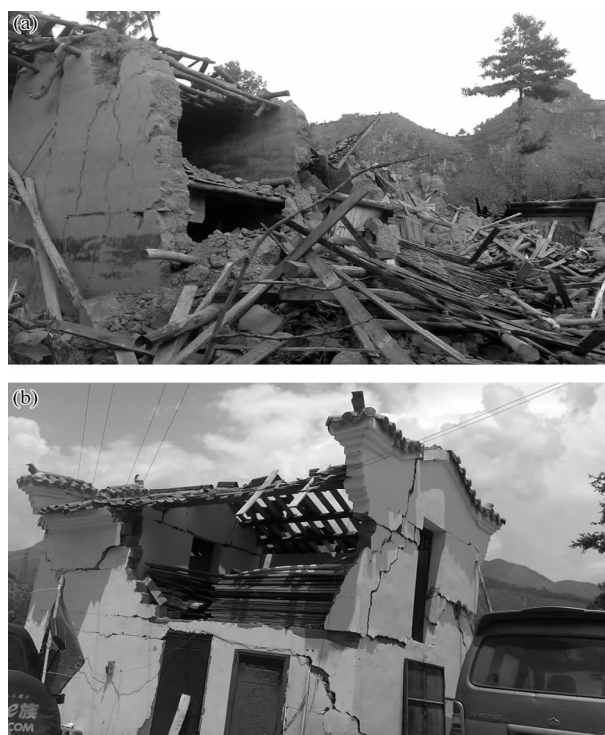
图2 鲁甸地震VIII度区二层土木房屋(a)和IX度区二层砖木结构房屋(b)毁坏
