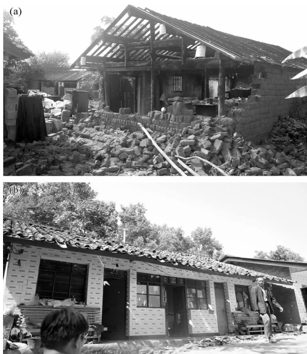
图4 景谷地震VIII度区单层土木结构 (a) 和砖木结构 (b) 房屋破坏
