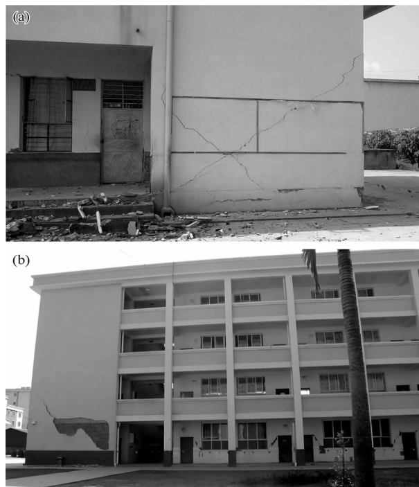
图5 景谷地震VIII度区砖混结构房屋严重破坏 (a) 和框架结构房屋中等破坏 (b)
