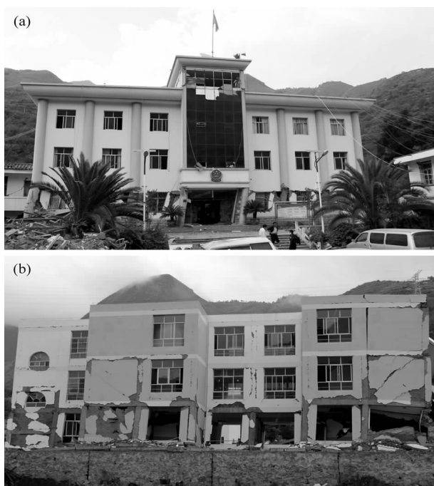
图3 鲁甸地震灾区IX度区砖混结构房屋毁坏 (a) 和框架结构房屋严重破坏
