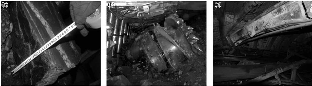
图 1 动力灾害对矿井巷道结构的破坏
