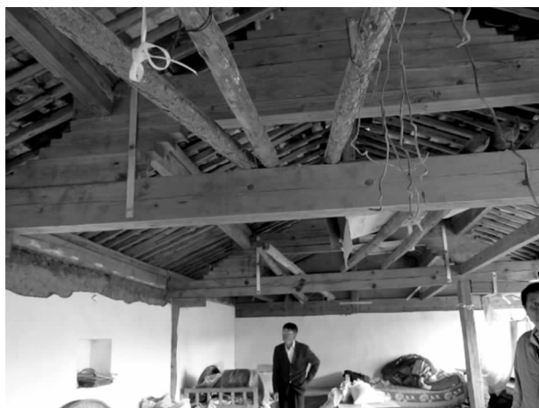
图3 “3·03”地震灾区维修加固房屋在云龙5.0级地震中表现良好
