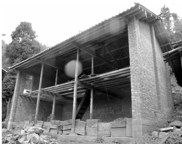
图4 云龙5.0级地震灾区新建砖木结构房屋木构架节点加固
