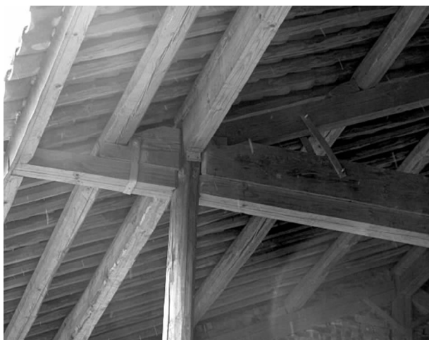
图4 云龙5.0级地震灾区新建砖木结构房屋木构架节点加固
