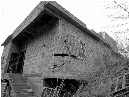
(a) 龙头山镇祭龙山社砖混结构外挑窗角剪切破坏
