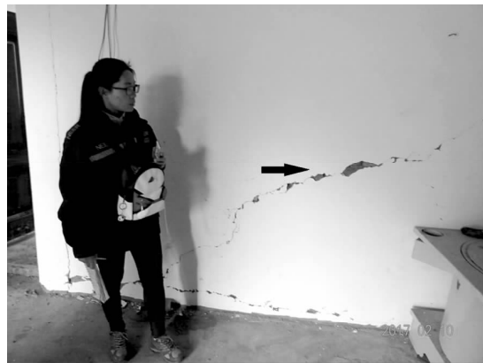
(b) 龙头山镇沿河村砖混结构墙体斜裂
