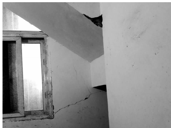
(d) 火德红镇烂泥箐村砖混结构窗角轻微裂缝、楼梯间墙皮局部掉灰块
