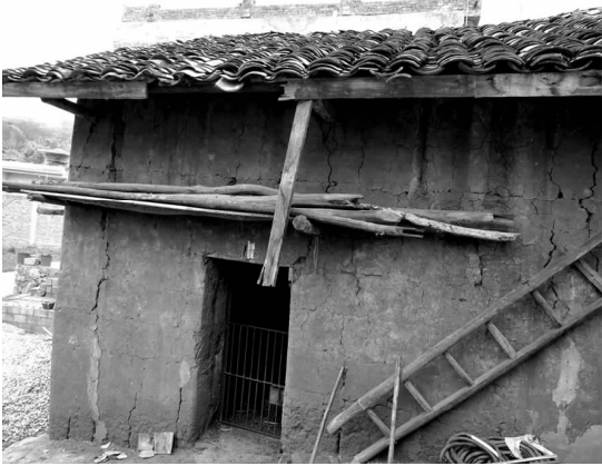
(b) 龙头山镇沿河村土木结构老裂缝加宽、木架部分折断
