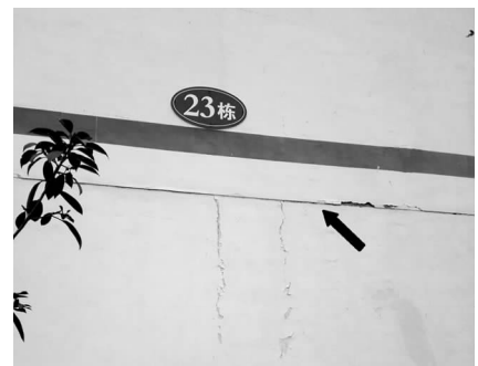
(c) 外墙梁柱结合部轻微裂缝
