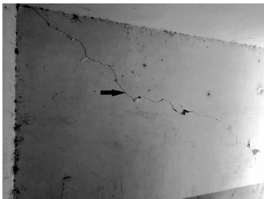
(c) 龙头山镇沙坝村砖混结构墙体老裂缝加宽
