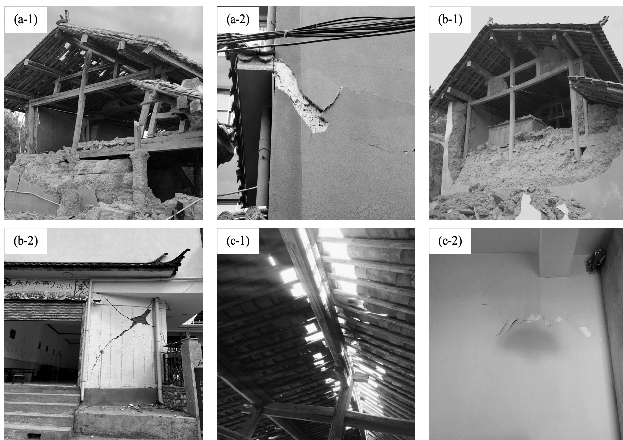
图2 漾濞 M_s6.4 地震各烈度区房屋震害
