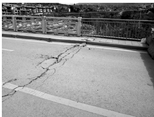
(e) 雪山河三大桥桥台与主梁接触部位开裂
