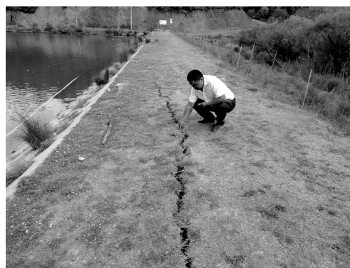
(f) 苍山西镇大浪坝水塘坝顶表面出现裂缝
