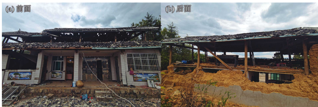
图4 居住房墙体破坏情况 Fig. 4 Main house's wall collapse
