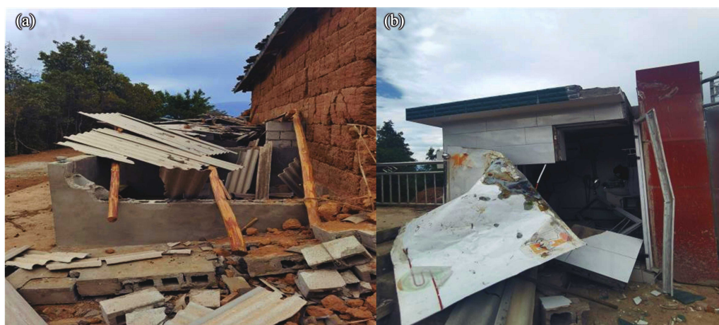
图8 畜圈房（a）和洗漱房（b）破坏情况
