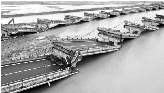
图2 2021年青海玛多 M_s7.4 地震中遭到破坏的桥梁(张昊宇摄)
