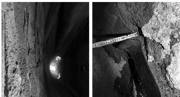
(a) 混凝土开裂脱落
