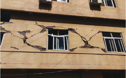
(d) 泸定地震中窗洞间墙脆性剪切破坏
