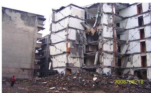
(c) 汶川地震中砖混结构楼板与梁连接薄弱
