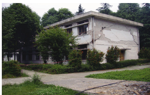
(f) 汶川地震中山墙无加固措施破坏
