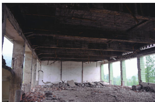
(b) 单跨结构一层破坏
