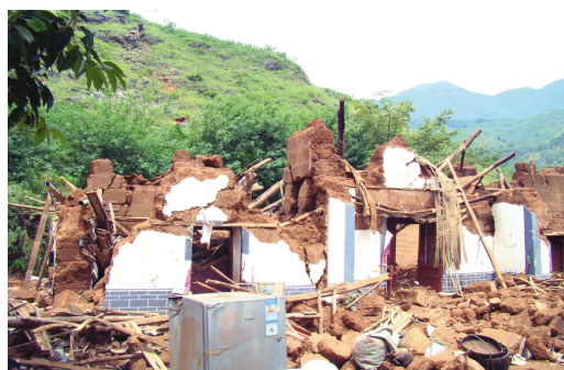
(b) 土木结构整体破坏
