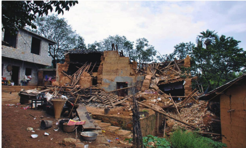
(a) 漾濞地震中土木结构夯土墙破坏
