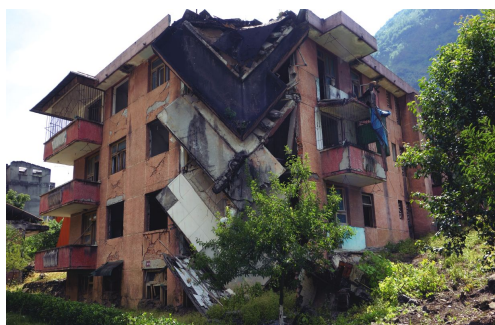
(a) 建筑一角连续倒塌破坏
