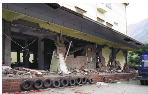
(e) 汶川地震中框架结构填充墙与结构拉结措施缺失破坏
