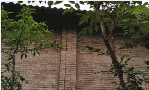
(b) 漾濞地震中砖木结构砖柱竖向裂缝
