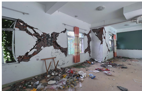
(d) 建筑一层C轴、D轴震害图
