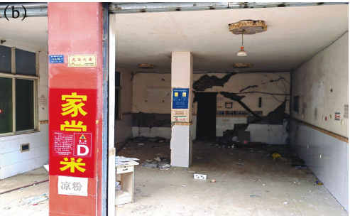
图 4 汶川地震 (a) 和泸定地震中 (b) 框架砌体混合结构一层震害
