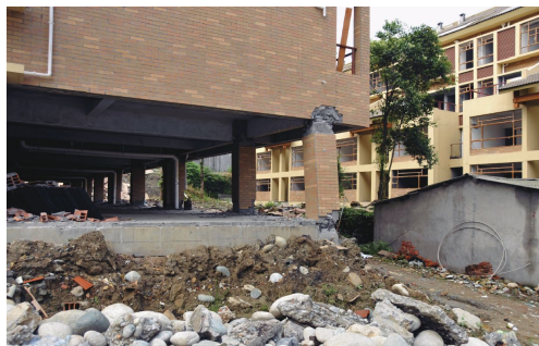
(a) 震区某建筑一层震害
