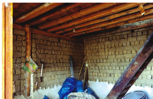
(a) 土木结构内部构造
