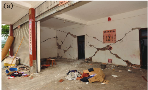
图 4 汶川地震 (a) 和泸定地震中 (b) 框架砌体混合结构一层震害
