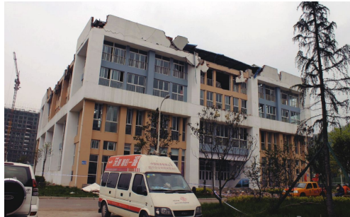
(d) 芦山地震中女儿墙加固措施不足掉落破坏
