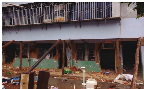
(b) 鲁甸地震中砌体结构门窗洞口两侧无构造柱
