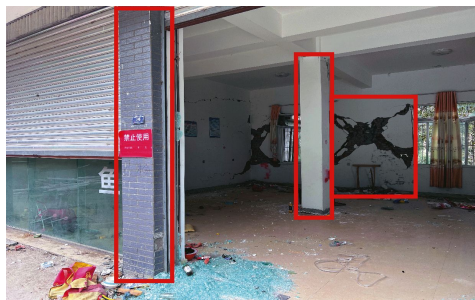
(c) 建筑物一层纵向不同构件震害对比
