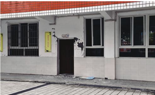
(f) 长宁地震中门窗洞口间矮墙脆性破坏
