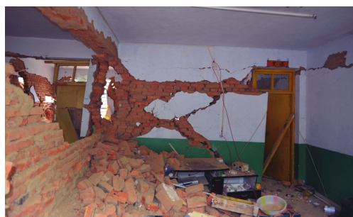
(a) 鲁甸地震中砌体结构纵横墙间无构造柱
