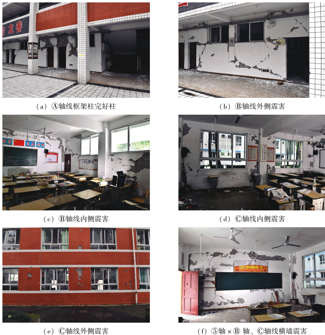
图8 双河中学教学楼一层各轴线震害
