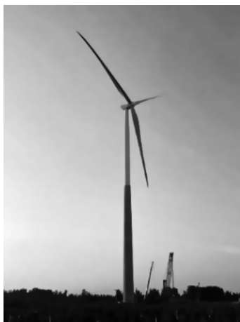
图 1 钢 - 混凝土混合风电塔
